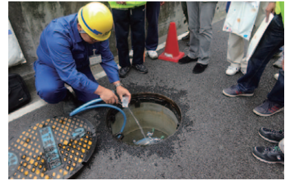
上下水道局による訓練
