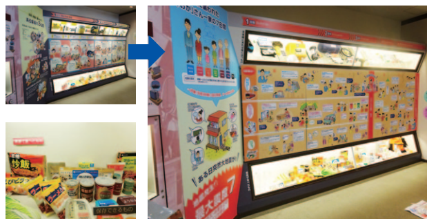
防災展示コーナー 壁面改修（岡崎市役所 防災コーナー）
