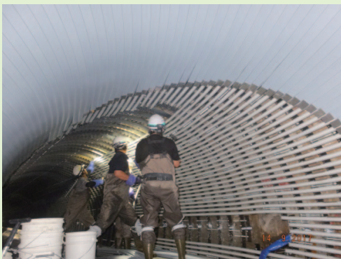
直線管路だけでなくカーブした既設管内にも新たな管路を形成できます
