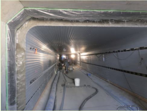
ボックス形状の既設管路内にも新たな管路を形成できます(長野県内の接項現場)
