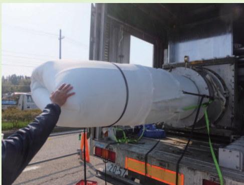
発信側・到達側二か所を掘削ピットから車載式の反転挿入機で施工する様子
