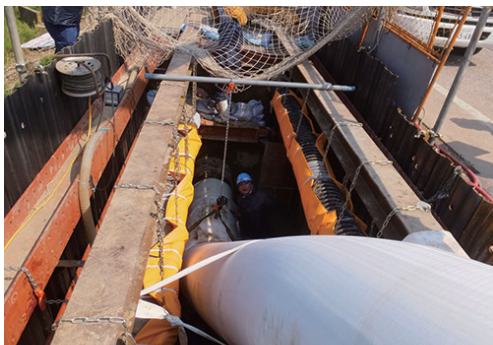
既設埋設管内にホースを反転挿入する ホースライニング工法
