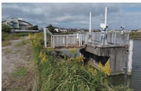
戸田川に雨水を注ぐ「水里ポンプ所(左側の建物)」
