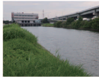
日光川と合流する最下流部にある戸田川排水機場
